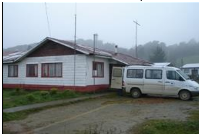
FOTO N° 1-2: Posta de Estaquilla
