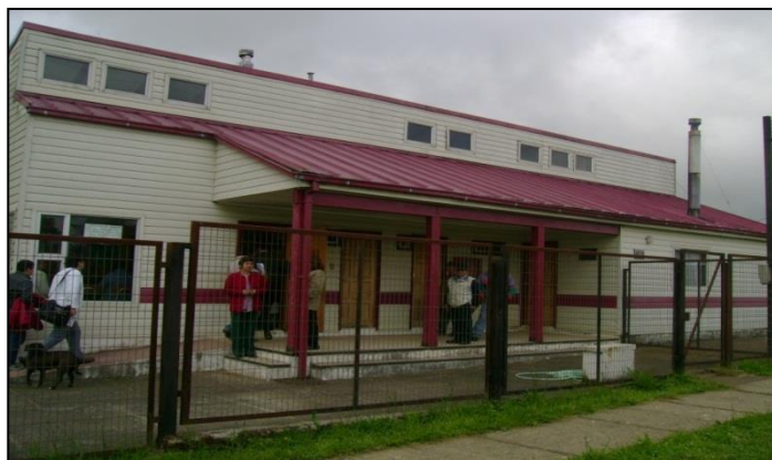
FOTO N° 1-1: Posta de Cañitas
